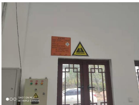
其他危险废物暂存间
