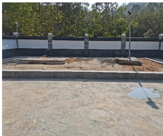
柴油罐区防火堤
