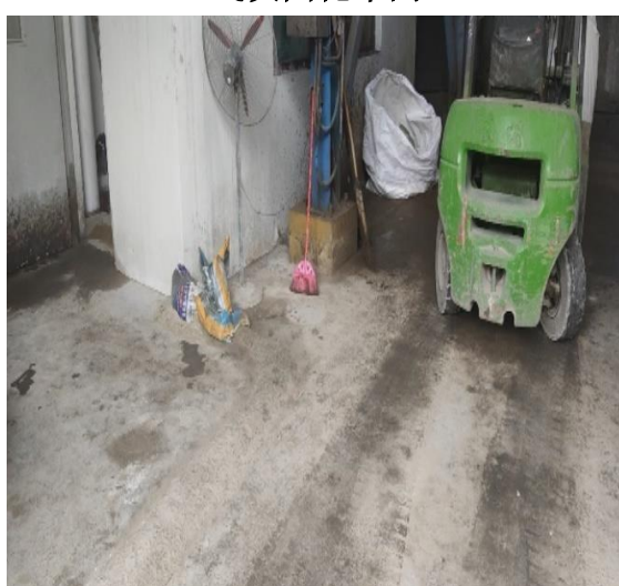
飞灰固化车间地面防渗
