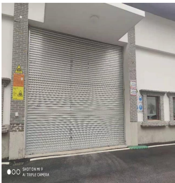
飞灰固化块暂存间
