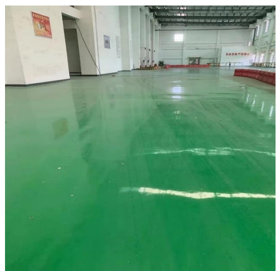
卸料大厅防腐防渗
